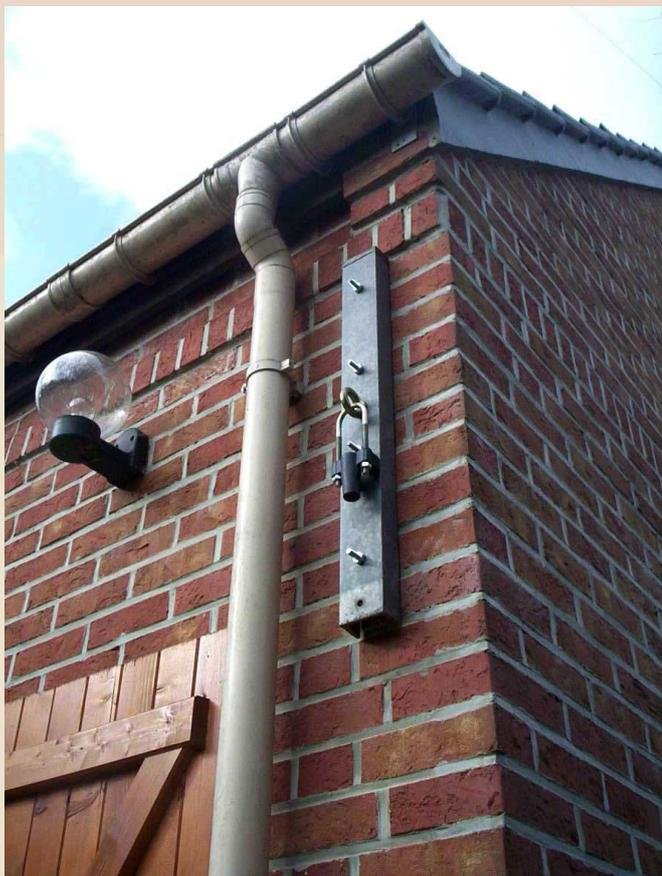
ajoutés en pied, trouvables en grandes surfaces de bricolage. Le pylône étant autoportant pour de faibles charges, le haubanage est là pour sécuriser lors de grands vents et tempêtes, surtout si une antenne pour la HF y prend place aussi. Ainsi j'ai décidé 3 pieds de haubans, et 2 nappes de 3 haubans. La première à 6 m de hauteur, soit aux 2 premiers éléments. La dernière en tête, soit au faite de la cage à rotor. La disposition des haubans a privilégié 2 fixations côté vents dominants.
