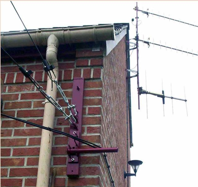
grossissant la première étape de tension. Le montage des connexions CU1 est assez facile, mais je recommande de laisser plus de dépassement au câble en sortie de celles-ci, que préconisée. J'ai d'ailleurs dû modifier le montage du départ, pour avoir suffisamment de réglage aux dites connexions et aux tendeurs. On peut voir sur la photo.
