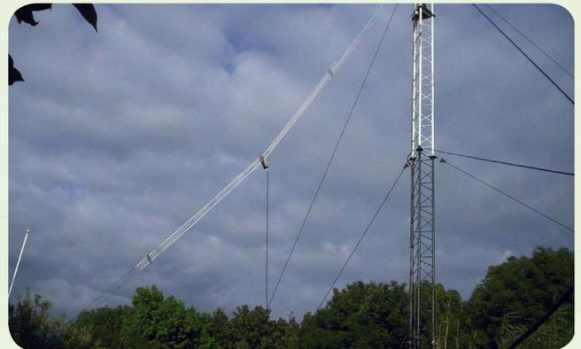
Sur la dernière photo, l'ombre en bas de l'antenne, après le disque intermédiaire, masque la longueur des éléments qui est différente comme en hauteur, puisque centrée au milieu de l'antenne. Le réglage de longueur des dipôles s'est fait à chaque fois des deux côtés. Les tendeurs côté sol sont hors champ de la photo.
