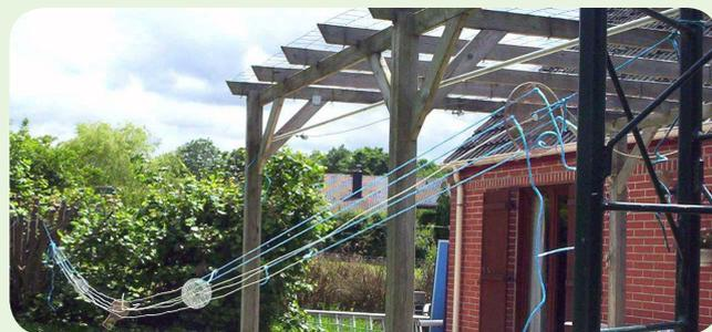
Des tendeurs 3 trous sont utilisés d'un côté, sur la corde derrière le dernier écarteur, pour obtenir une tension équilibrée des dipôles. Ils seront placés côté sol. Un côté de l'assemblage est monté sur le pylône à 11 m, avec
