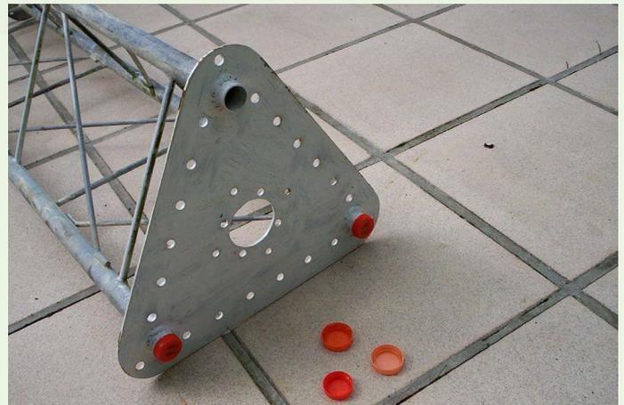
Ainsi, armé d'une bonne quantité de bouchons de divers diamètre, j'ai pu bouchonner divers tubes. Mon tube de pignon, n'avait pas trouvé exacte chaussure à son pied (sic), mais un peu de colle silicone (non acide) l'a aidé à être «couvert». Quant aux extrémités de mon élément de pylône, bonne pioche, certains diamètres de bouchon s'enfoncent idéalement à force.
