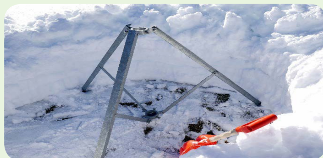
Installation du support d'antenne...
