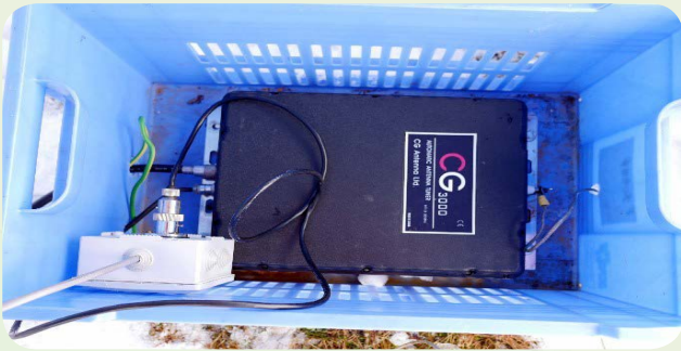
La boîte d'accord est câblée et fixée dans sa boîte de protection...
